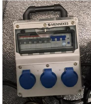
20 kWh : 1 P17 32 A + 1 P17 16 A + 10 prises sur 6 circuits de 3 kWh.
